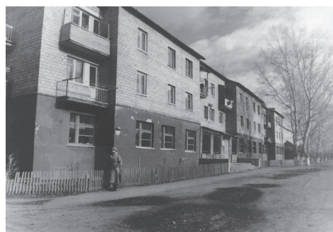
Здание, в котором находится библиотека с 1982 г.
